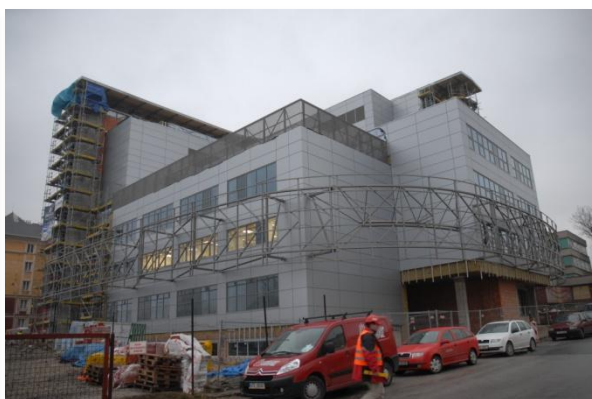
Prosinec 2009 – dokončování fasády, montáž technologií
