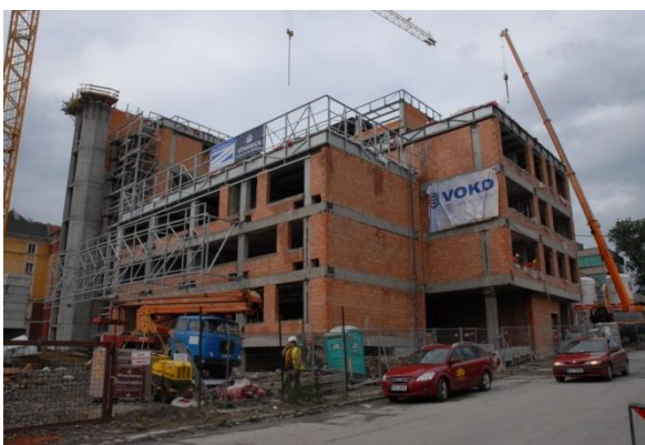
V červnu 2009 se stavba začínala rýsovat
