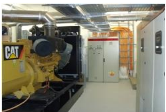
Jeden ze dvou modulů nepřetržitého napájení 500 kW
