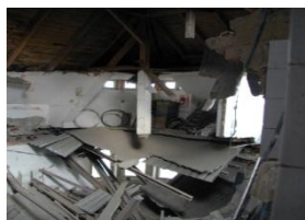
střecha MD Ostravica 2000
