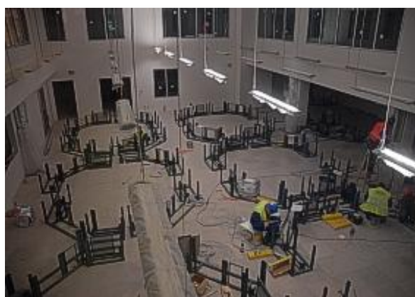
Zahájení montáže dispečerských stolů. Na těchto fotografiích je zřejmé, že jde spíše o „technologická pracoviště dispečerů“
