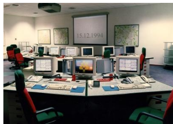
předání stavby CTV 1994
