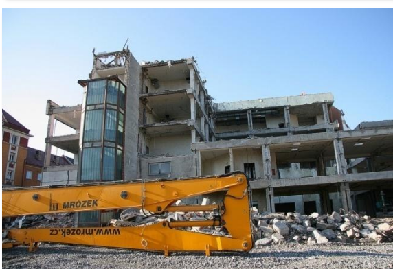
Prvním úkolem zhotovitele bylo úplné odstrojení a vyčištění nosného skeletu objektu META a jeho příprava k rekonstrukci
