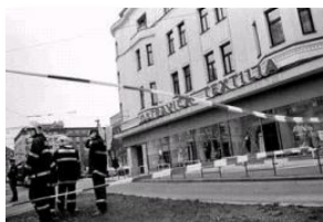
střecha MD Ostravica 2000
