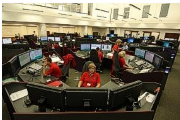
Celkový pohled na dispečerský sál IBC
