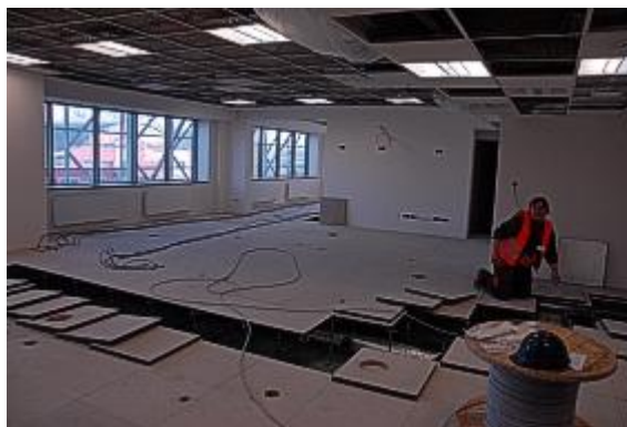
Montáž kabeláží do zdvojených podlah
