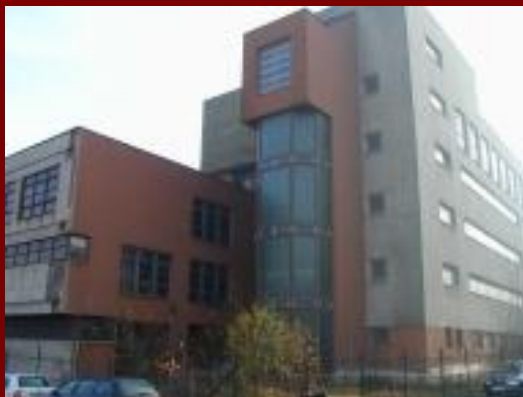
Pohled od ul. Nemocniční ...
